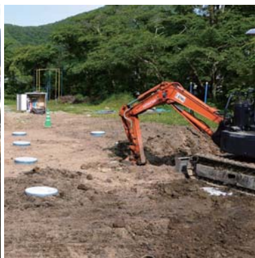
▲廃校を活用した共同研究施設。地中熱利用研究では我が国最大。第1棟、第2棟地中熱交換器の設置が着々と進む
